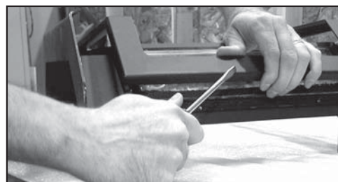
Figure 8.3 Utilisez un tournevis plat pour dégager le frontiscipe noir du côté droit. Enlevez le frontiscipe et jetez le.
