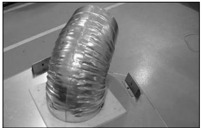
Schéma 7.6 Attachez la première section du conduit d'évacuation.
