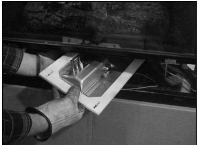
Schéma 12.5 Assemblage de la valve.
