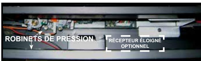
Figure 11.5 Localisation des robinets de la vanne de pression et du récepteur éloigné
