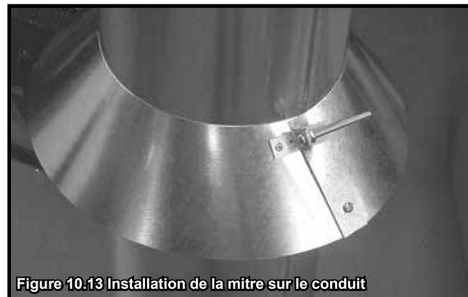
**Figure 10.13** Installation de la mitre sur le conduit
