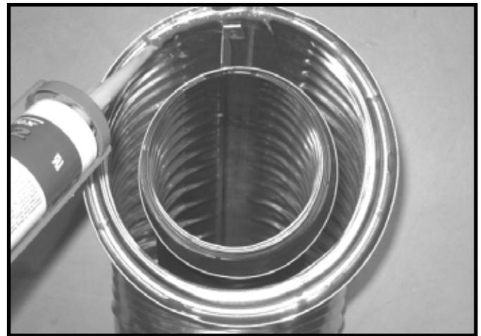
Figure 10.2 Scellant de silicone à haute température
