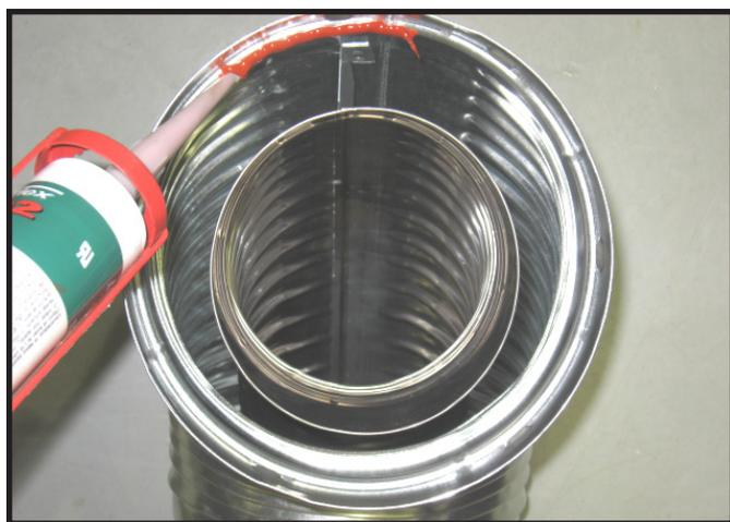
Figure 10.2 Scellant à la silicone pour haute température
