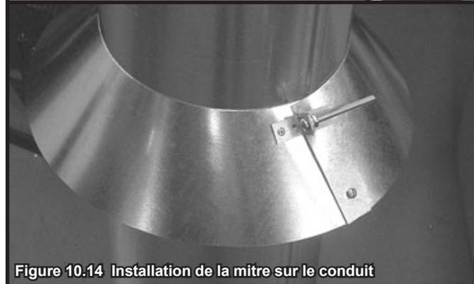
**Figure 10.14** Installation de la mitre sur le conduit
