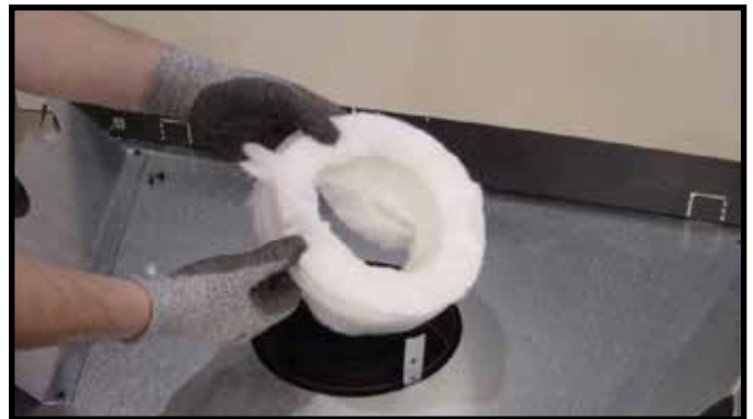
Figure 9.5 Retirez l'isolation du tuyau de conduit extérieur. Dans le cas d'évacuation arrière, il n'y a pas d'isolation dans le tuyau du conduit extérieur.
