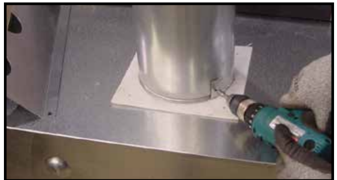
Figure 9.6 Pour attacher la première section du tuyau d'évacuation, assurez-vous d'utiliser le joint en fibre de verre expédié dans la pochette du manuel pour sceller le premier tuyau à l'enveloppe extérieure du foyer. Utilisez 2 vis autotaraudeuses pour attacher le joint à l'enveloppe extérieure. Un mastic d'un indice d'exposition continue d'un minimum de 300° F.
