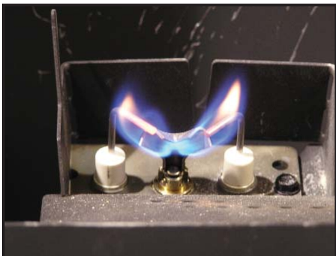
Figure 3.1 Forme de la flamme d'une veilleuse IPI
