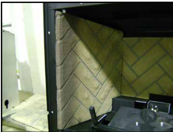
Figure 3. Installation de la brique réfractaire latérale
