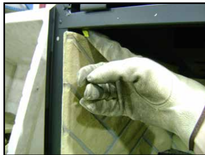
Figure 5. Plier la languette du réfractaire
