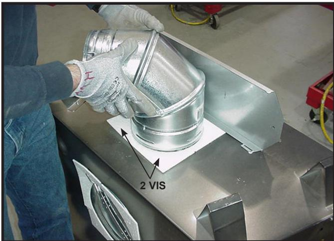
**Figure 6.7** Pour fixer la première section du conduit d'évacuation, assurez-vous d'utiliser le joint d'étanchéité en fibre de verre pour sceller entre le premier composant et l'enveloppe extérieure du foyer. Utilisez 2 vis autotaraudeuses pour fixer le joint d'étanchéité à l'enveloppe extérieure.
