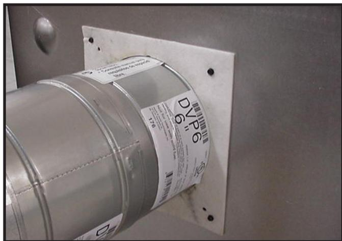
**Figure 6.12 (foyer générique montré)** Posez la première section du conduit d'évacuation (elle s'insérera en place d'un bruit sec). Glissez le joint d'isolation sur cette section du conduit, contre l'appareil, en passant sur les languettes. Utilisez deux vis autotaraudeuses pour fixer le joint à l'enveloppe extérieure.
