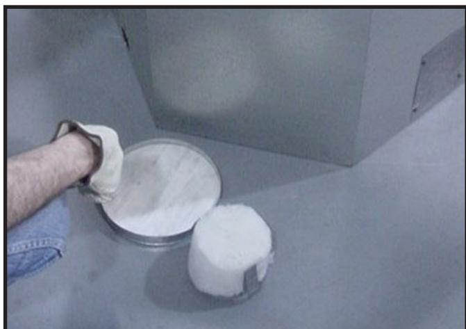
**Figure 6.11 (foyer générique montré)** Jetez le couvercle du conduit, enlevez et jetez le panier d'isolant. Remarque : Une fois enlevé, le couvercle du conduit **NE PEUT PAS** être remis.
