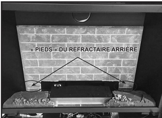
Figure 11.3 Installer la pièce arrière du réfractaire
