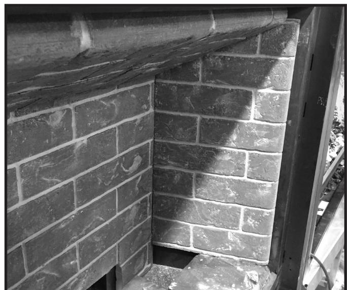
Figure 11.7 Panneau du réfractaire droit installé
