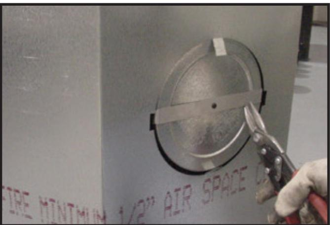
**Figure 6.9 (foyer générique montré)** Coupez la bande métallique de retenue et pliez les deux parties coupées vers l'extérieur.
