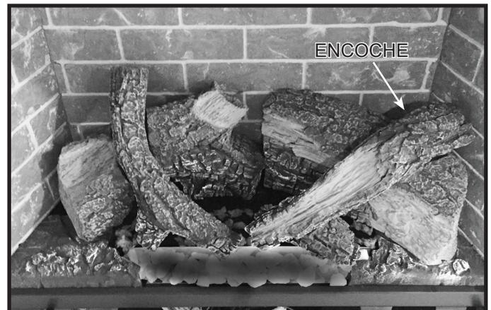
Figure 9. Bûche supérieure droite installée - Jeu de bûches complet
