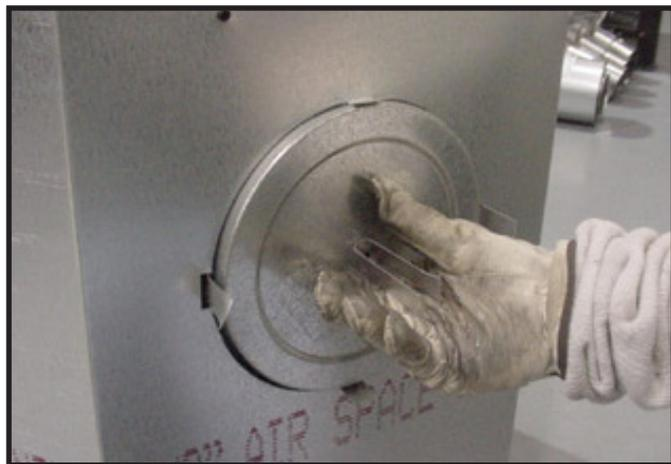
**Figure 6.10 (foyer générique montré)** Repliez vers l'extérieur les parties centrales de la bande de retenue et les utiliser pour enlever le couvercle du conduit.
