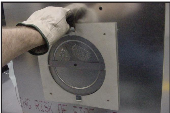
**Figure 6.8 (foyer générique montré)** Pliez les languettes vers le centre du branchement au feu (90°) puis enlevez le joint d'isolant.
