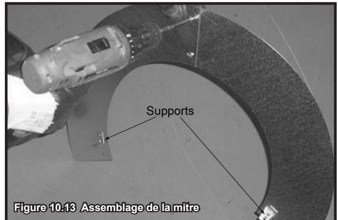
**Figure 10.13** Assemblage de la mitre
