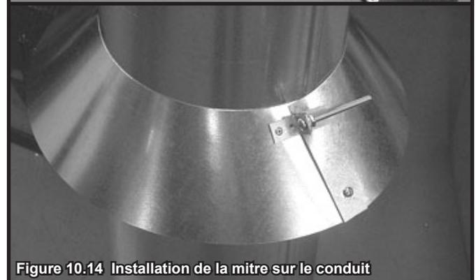
**Figure 10.14** Installation de la mitre sur le conduit
