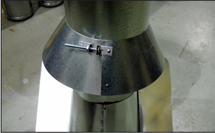
Figure 7.14 Insérer le boulon dans les supports
