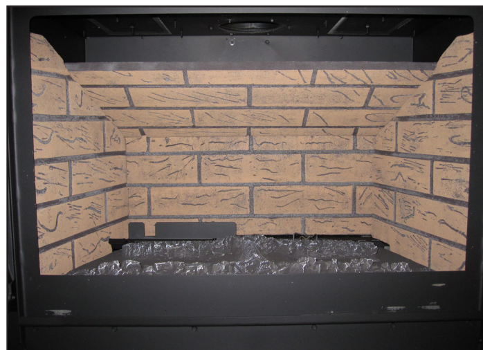
Figure 10.8 Réfractaire installé
