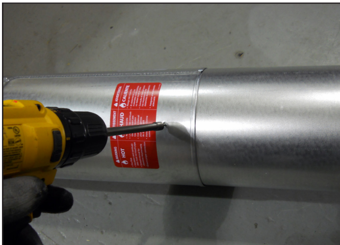
Figure 7.4 Vis sur la section coulissante
