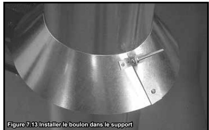
Figure 7.13 Installer le boulon dans le support
