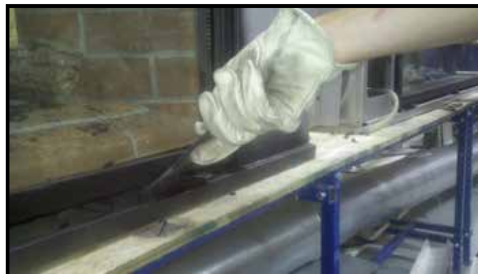
Figure 11.3. Insérer l'outil du clip de vitre
