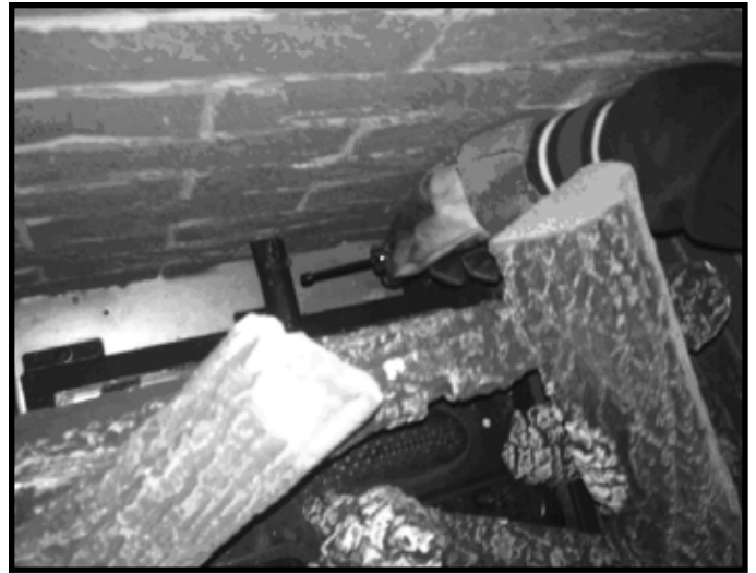
Figure 1. Emplacement de l'obturateur d'air
