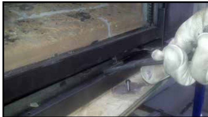
Figure 11.2 Emplacement de l'outil du clip de vitre
