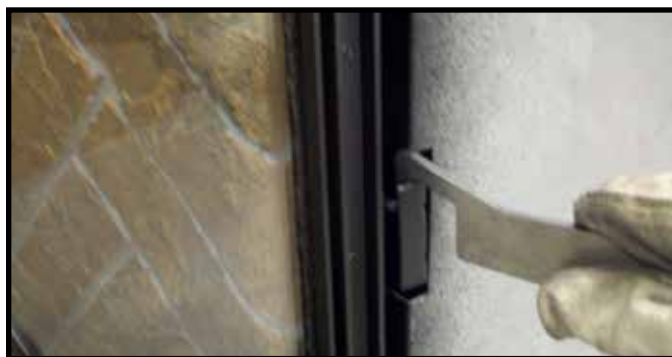
Figure 11.7. Sécuriser les clips de verre latéraux
