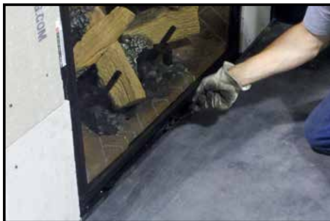
Figure 11.8. Sécuriser les clips de verre inférieurs
