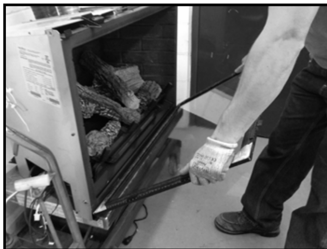
Figure 11.4 Incliner la vitre vers le bas et soulever pour dégager le verrou du bas.
