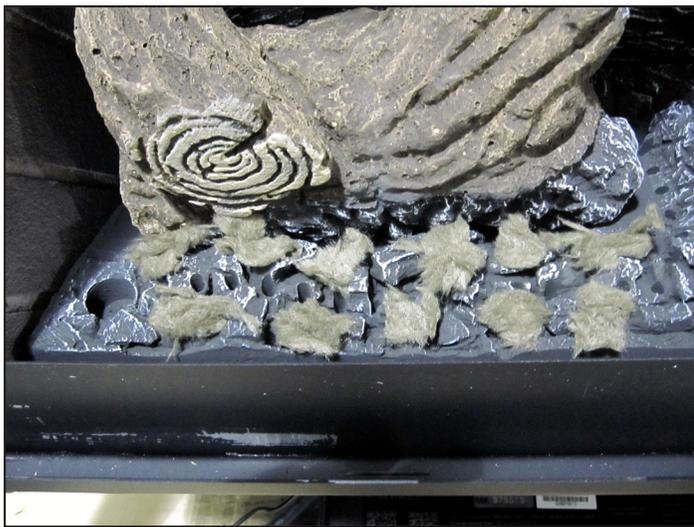
Figure 10.13 Placer la laine isolante
