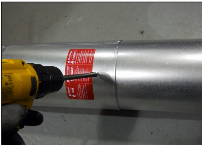
Figure 7.4 Vis de la section coulissante
