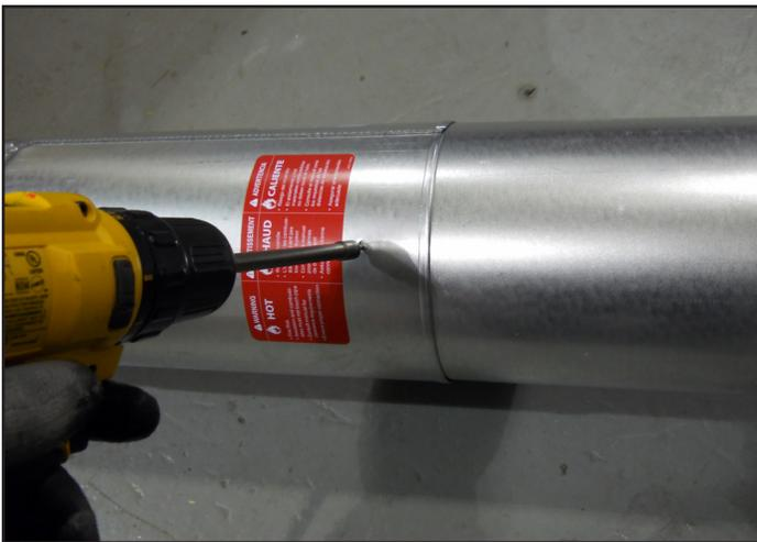
Figure 7.4 Vis de la section coulissante
