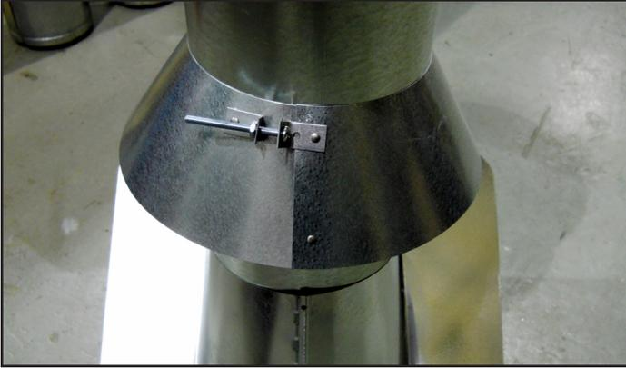
Figure 7.14 Insérer le boulon dans les supports
