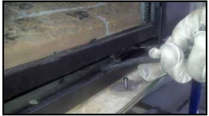
Figure 14.7. Emplacement de l'outil de mise en place et de retrait de la vitre
