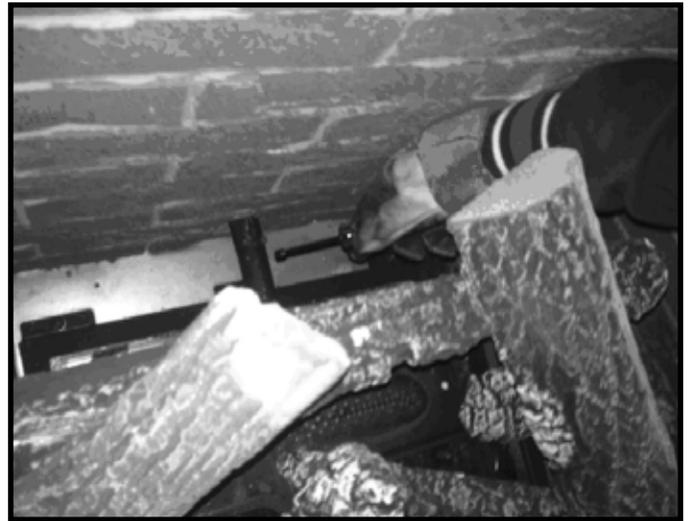
Figure 1. Emplacement de l'obturateur d'air
