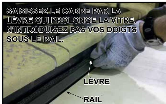
Figure 14.11. Installation de la vitre
