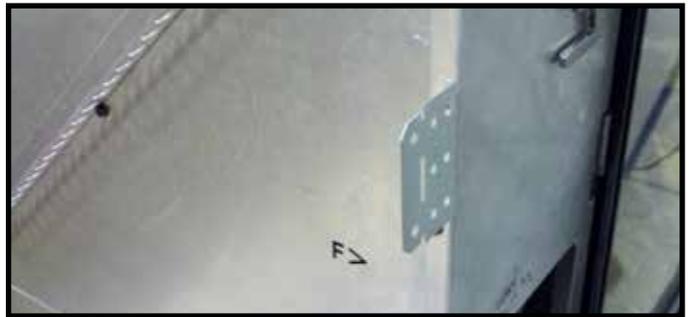
Figure 9.4 Patte à clouer pliée vers l'extérieur pour l'installation
