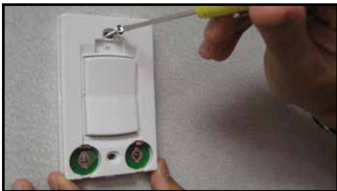
Figure 2. Montage de l'interrupteur mural sans fil
