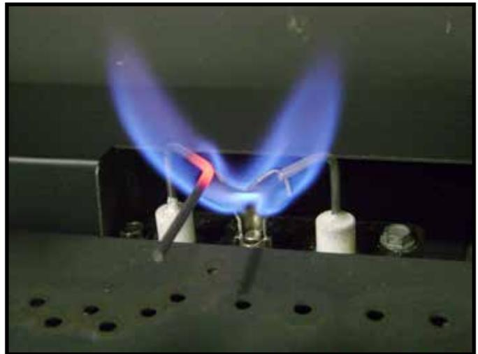
Figure 3.2 Modèles de flamme de la veilleuse IPI
