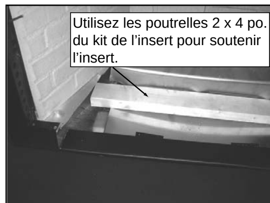
Figure 10.3 Si le fond est en tôle, nous recommandons d'utiliser les poutrelles de 2 x 4 pouces livrées avec l'insert et conçues pour le soutenir. Il se peut qu'il soit nécessaire de couper les poutrelles à la longueur voulue.
