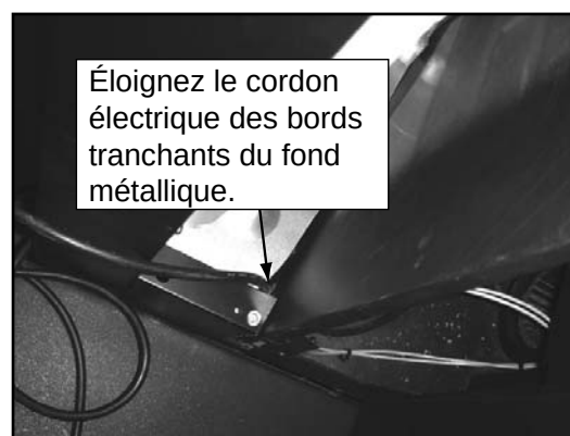
Figure 10.4. Placez l'insert dans la boîte à feu préassemblée. Assurez-vous que le cordon électrique ne puisse pas être endommagé par le bord métallique tranchant. Vous devrez peut-être découper une encoche pour le cordon.
