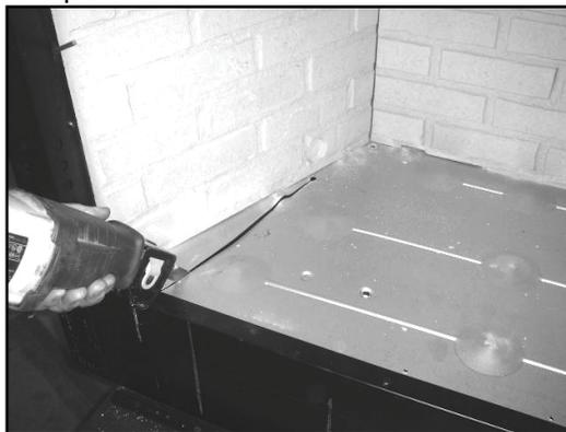
Figure 10.3. Découpez le fond en utilisant une scie à mouvement alternatif.
