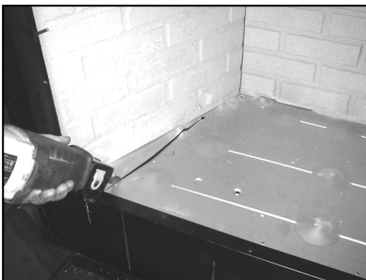
Figure 12.3. Découpez le fond en utilisant une scie à mouvement alternatif.
